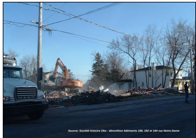
Démolition 2005 no 160, 162 et 164
